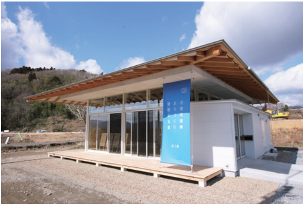
北上館 外観（館外の吊りサインを作成）
